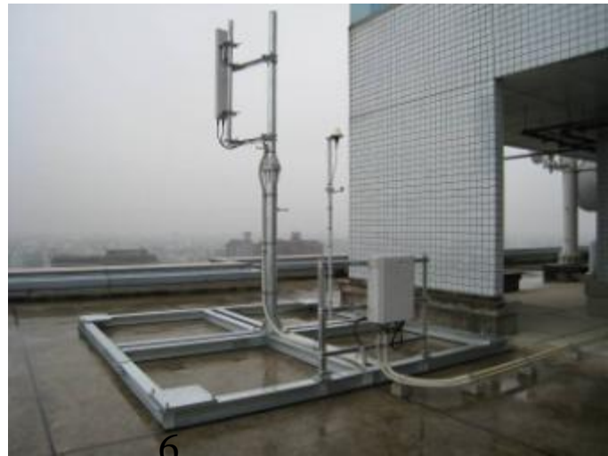
自治体ビル屋上
