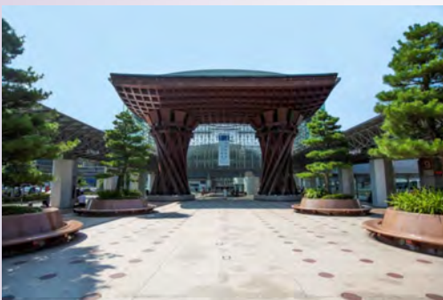
金沢駅東もてなしドーム (地上部及び地下部の一部)
