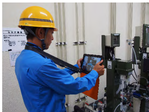
図 2. 上下水道の点検業務の様子
