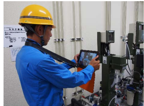
図 2. 上下水道の点検業務の様子
