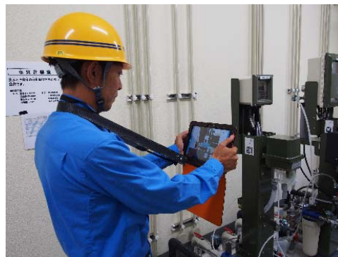
図 2. 上下水道の点検業務の様子
