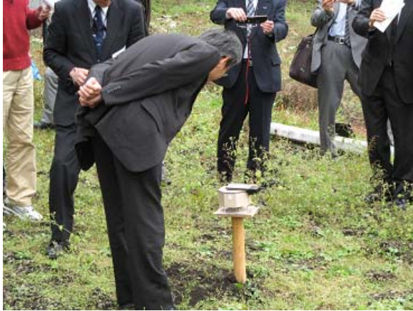
警報発信装置の設置状況
